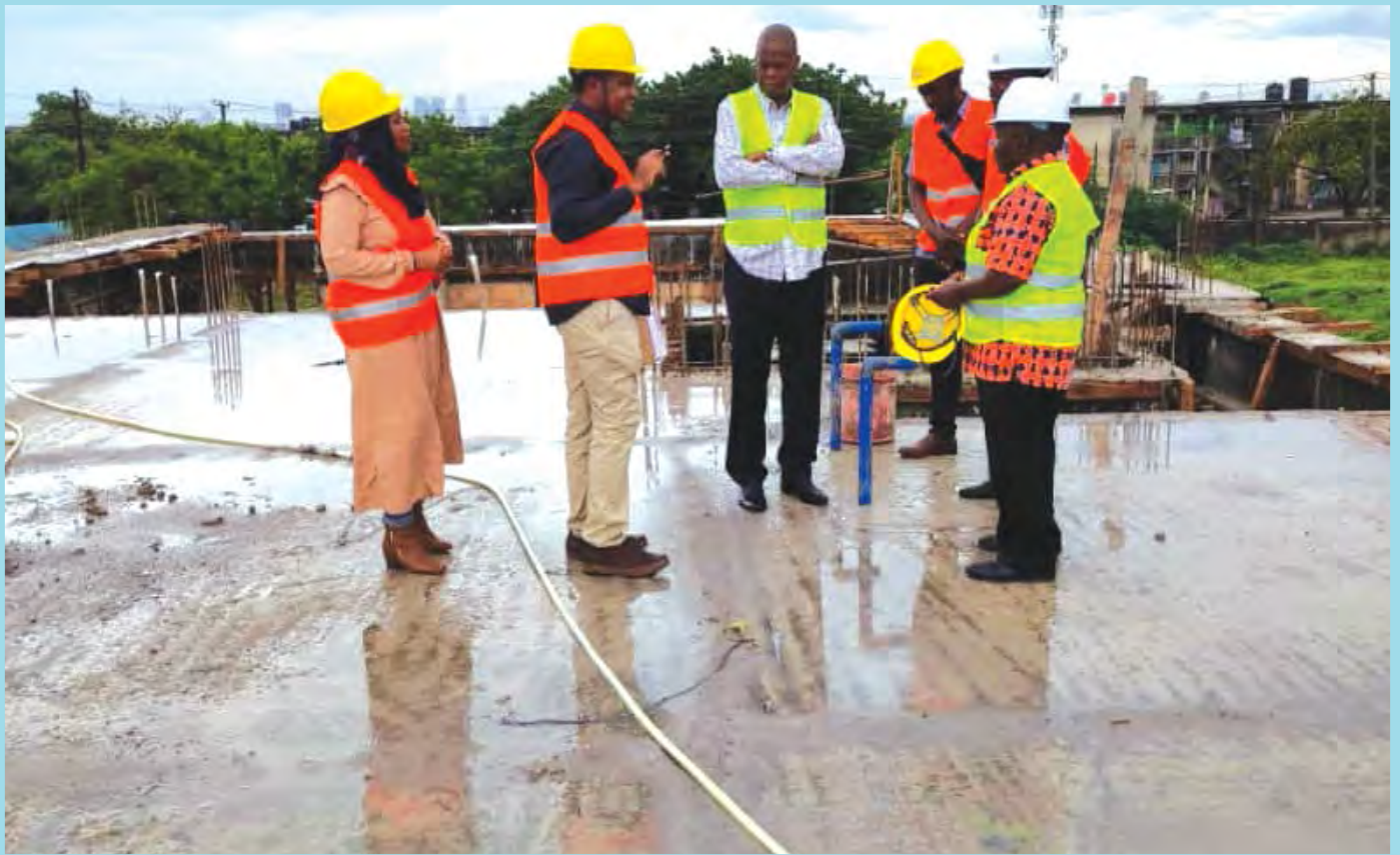
Katibu Mkuu Wizara ya Kilimo Andrew Massawe (wa tatu kutoka kushoto) akisikiliza maelezo ya Mwenyekiti wa Kamati ya Ujenzi wa Jengo la Maabara ya Mbolea linalojengwa katika eneo la kilimo III Temeke, jijini Dar es Salaam.
