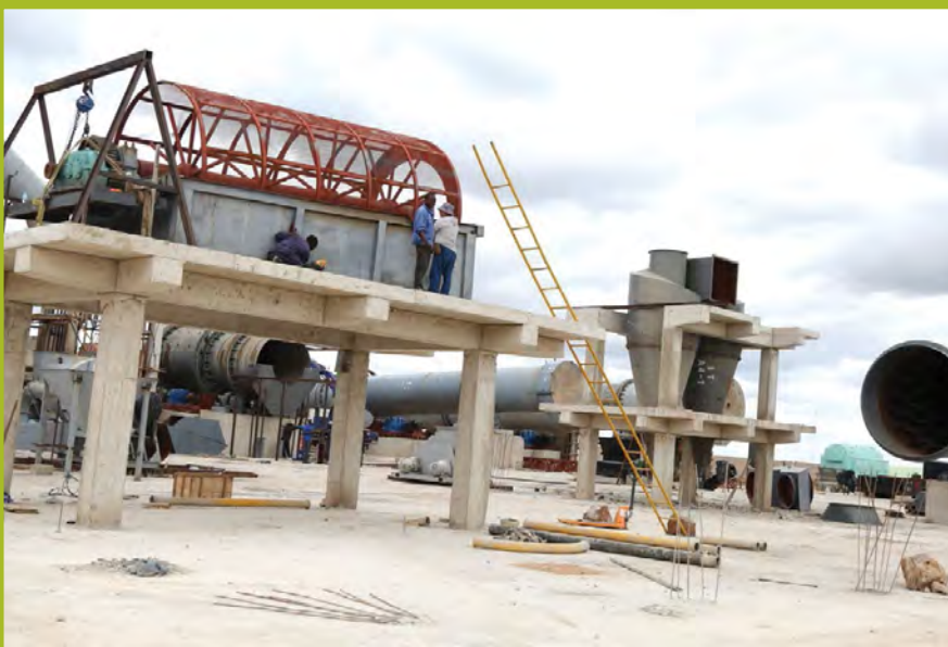
Baadhi ya mitambo iliyofungwa kwenye kiwanda cha mbolea cha ITRACOM Limited kinachojengwa jijini Dodoma
